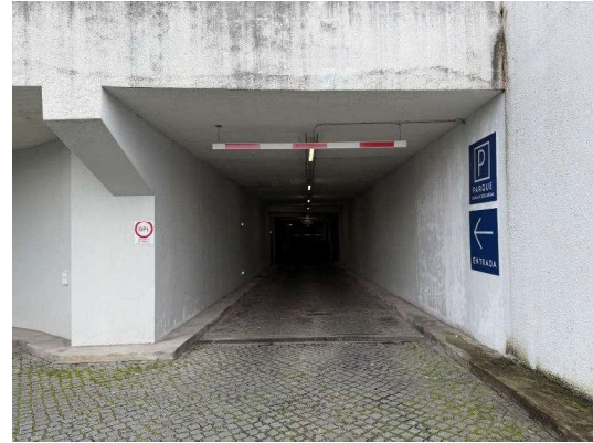
Figura 11A: Entrada de veículos na garagem do piso -1
