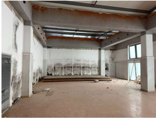
Figura 34A: Estado do anfiteatro na Unidade Suscetível de Utilização Independente C no Piso 1
