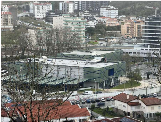
Figura 4A: Vista do imóvel do lado Sudoeste
