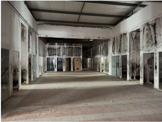
Figura 26A: Vista do espaço central na Unidade Suscetível de Utilização Independente C no Piso 1
