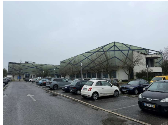
Figura 5A: Vista do imóvel do lado Sudeste
