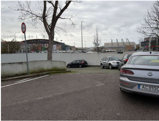
Figura 10A: Vista da rampa de entrada de veículos para o piso -1
