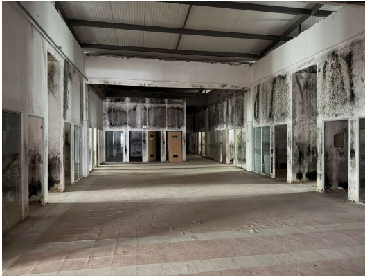
Figura 26A: Vista do espaço central na Unidade Suscetível de Utilização Independente C no Piso 1
