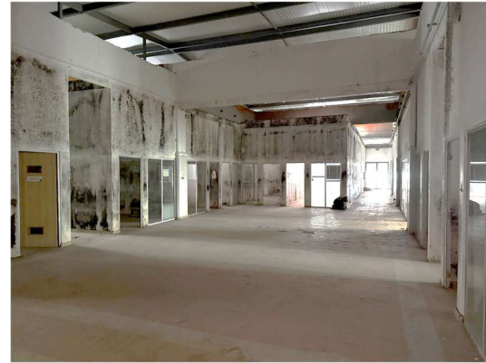
Figura 27A: Espaço central e gabinetes na Unidade Suscetível de Utilização Independente C no Piso 1
