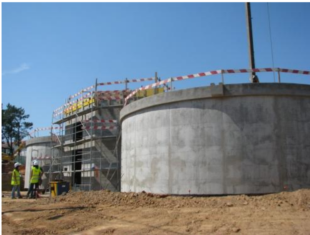
Figura 64. Reservatório da Barosa (à data da construção)
