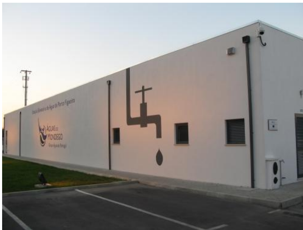
Figura 63. Estação Elevatória de Porto Figueira
