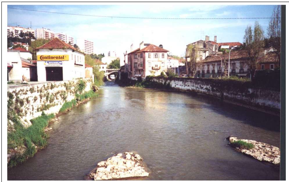
Foto 13 - Rio Lis - Aspecto do rio a montante da Ponte Engº Afonso Zuquete.
