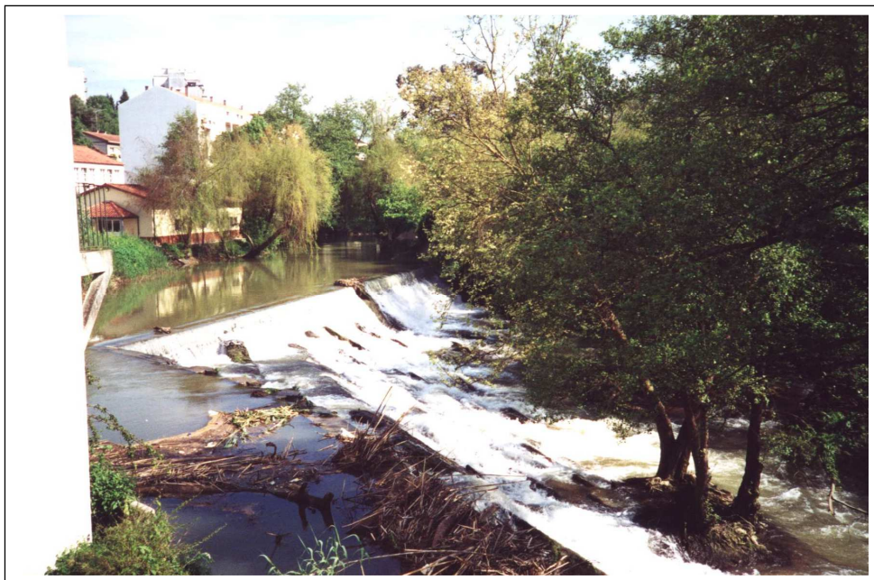
Foto 7 - Rio Lis - Açude do Moinho de Papel - Aspecto do Açude situado imediatamente a jusante da Ponte dos Caniços visto da margem esquerda.
