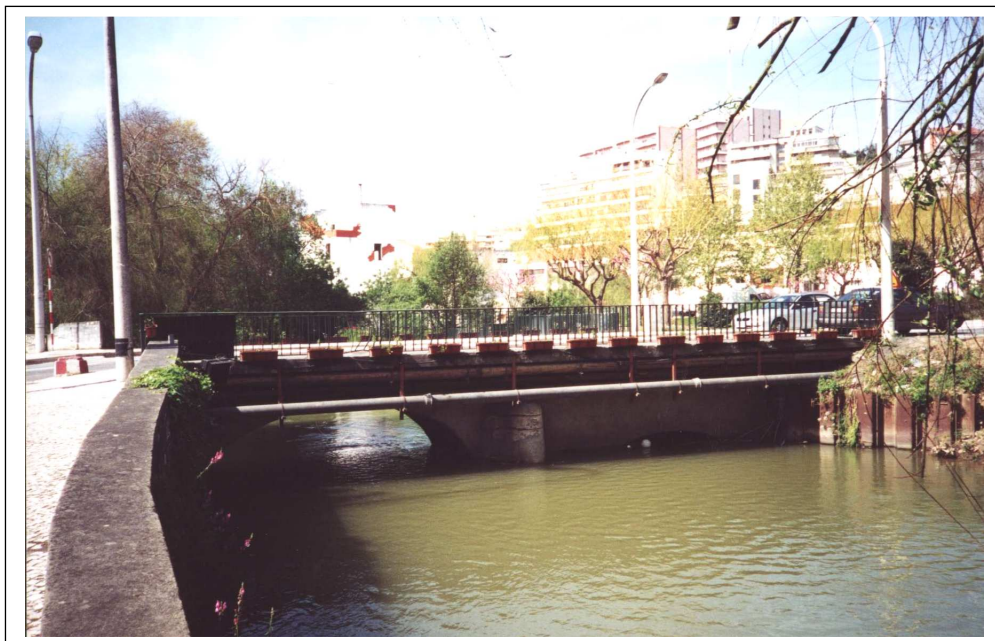
Foto 5 - Rio Lis - Ponte dos Caniços vista de montante. Pormenor do nível da água devido ao açude localizado a jusante da ponte.
