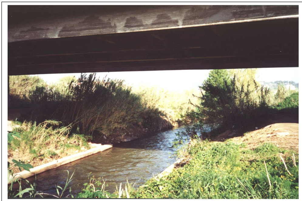
Foto 27 - Rio Lis - Vista sob a ponte da EN-1, para montante.
