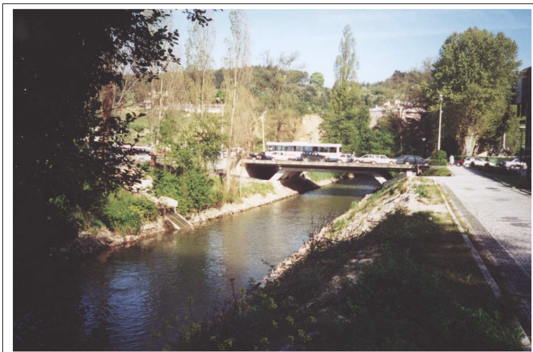
Foto 20 - Rio Lis - Ponte Sá Carneiro vista de jusante.
