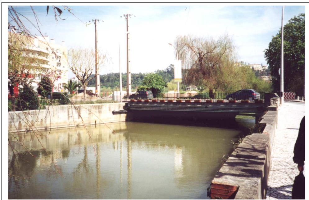
Foto 6 - Rio Lis - Ponte dos Caniços vista de jusante.
