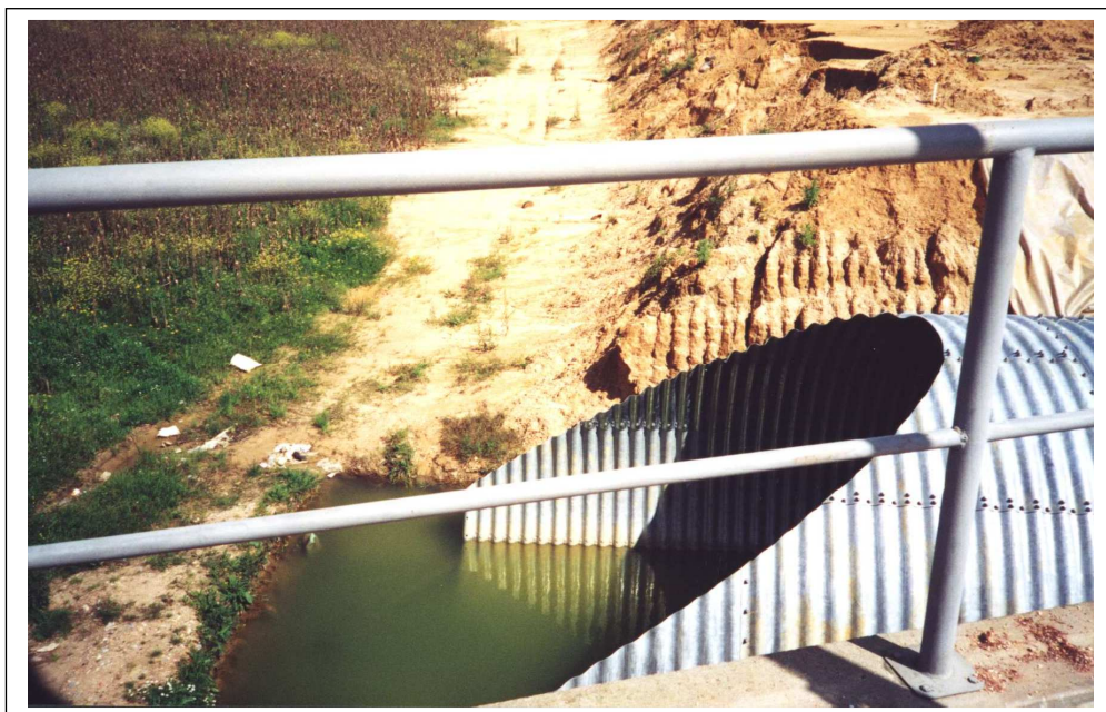
Foto 4 - Pormenor da boca de jusante do aqueduto sob o aterro da “Variante Sul” no limite sul dos campos da margem esquerda do Rio Lis.
