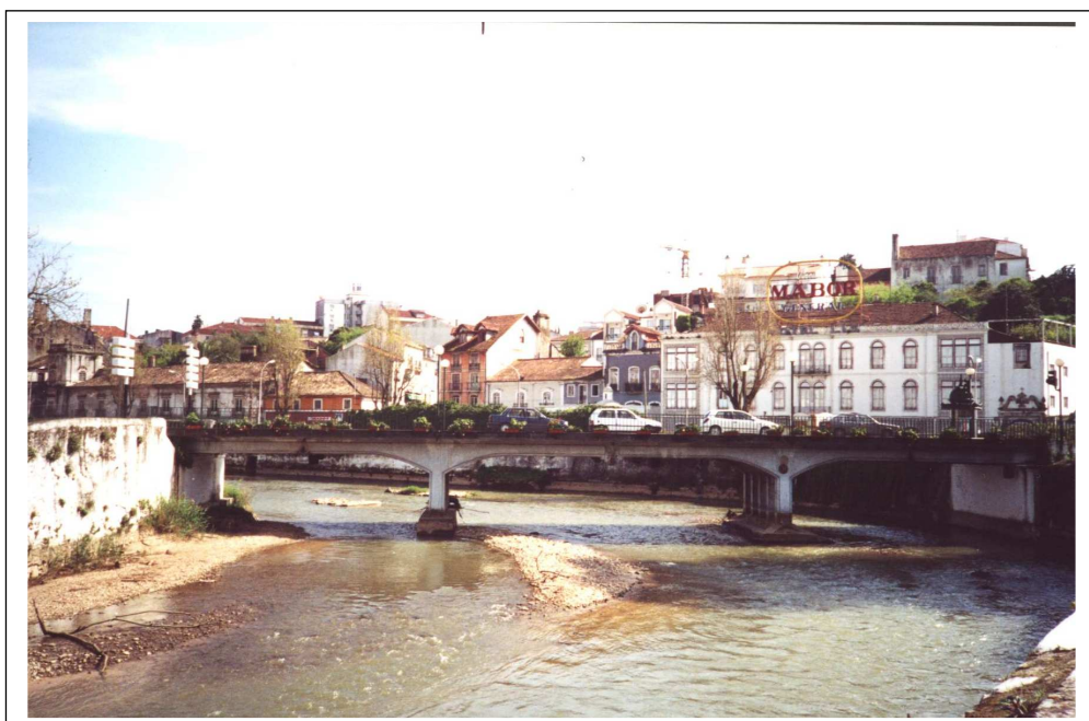
Foto 14 - Rio Lis - Ponte Engº Afonso Zuquete vista de jusante.
