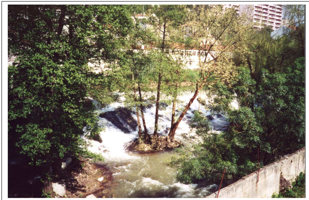
Foto 9 - Rio Lis - Aspecto da queda de água situada imediatamente a montante da Ponte Hintze Ribeiro.
