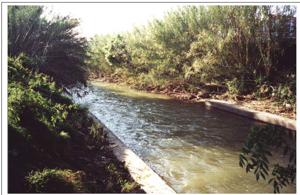
Foto 28 - Rio Lis - Vista sob a ponte da EN-1, para jusante.
