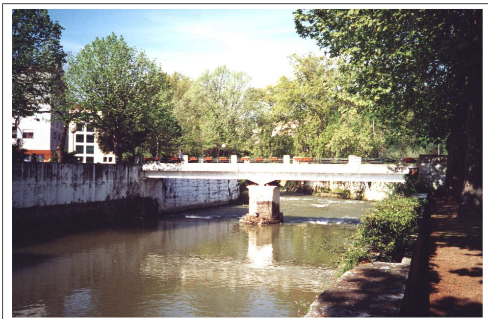
Foto 16 - Rio Lis - Ponte Pedonal / Açude junto à “Fonte Quente”
