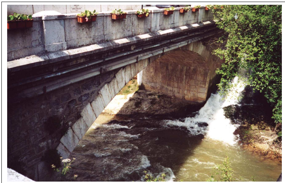
Foto 11 - Rio Lis - Ponte Hintze Ribeiro vista de montante da margem esquerda.
