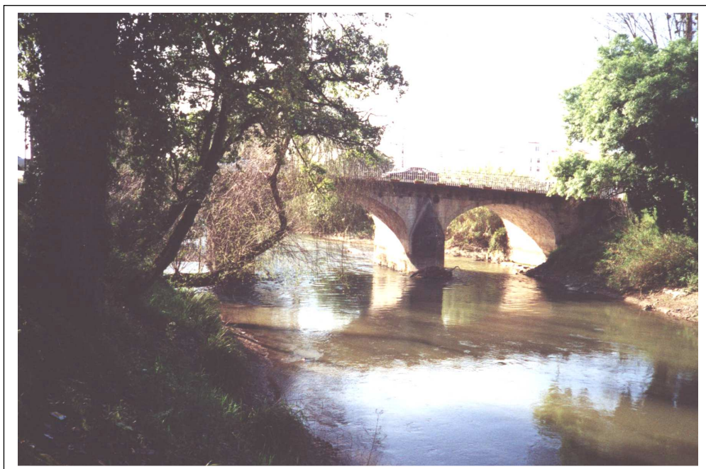
Foto 22 - Rio Lis - Ponte do Arrabalde vista de montante.
