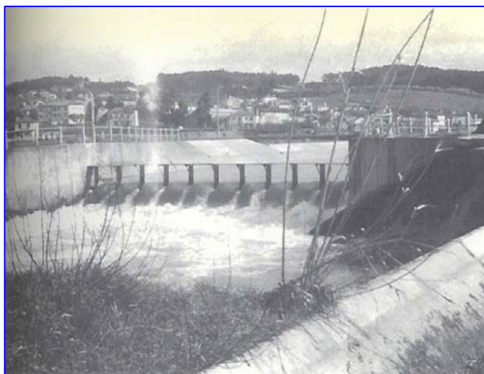
Fotografia 14 – Açude do Arrabalde - destruição do talude do dique da margem esquerda
