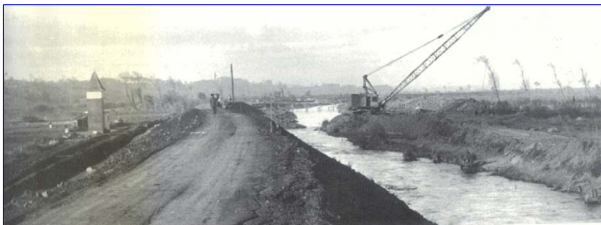
Fotografia 11 – Obras no rio Lis, junto à estação elevatória das Salgadas
