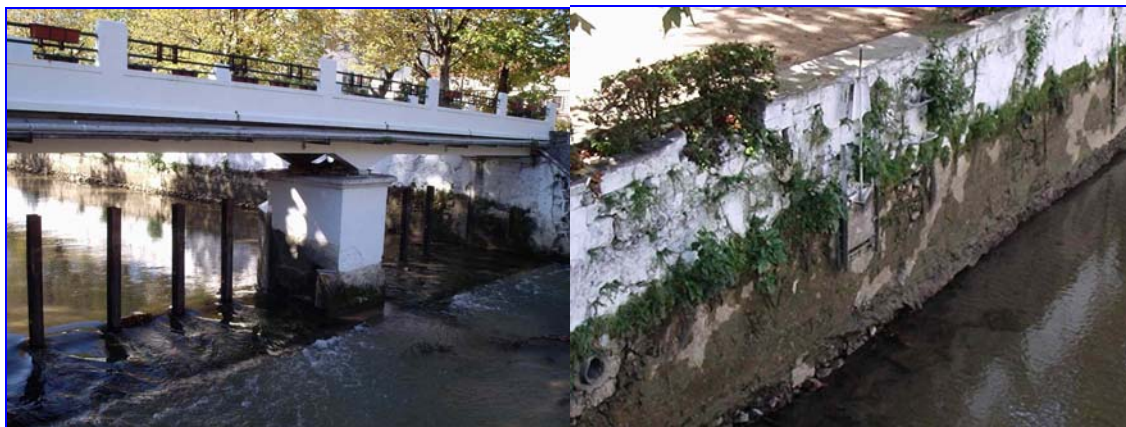
Fotografia 1 – Açude do Turismo e Tomada de Água da Regadeira do Turismo desactivada
