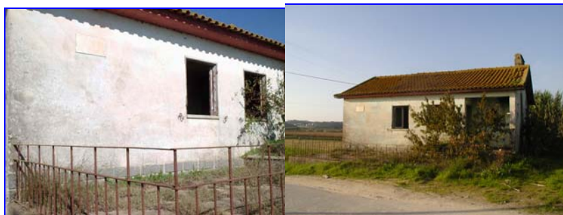
Fotografia 6 – Casa de Cantoneiros das Necessidades (1961)
