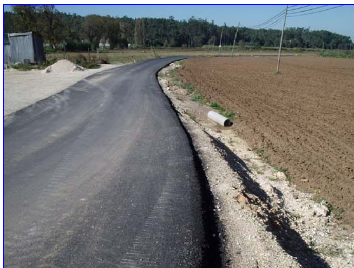
Fotografia 8 – Troço da Estrada do Campo Intervencionado pela SIMLIS
