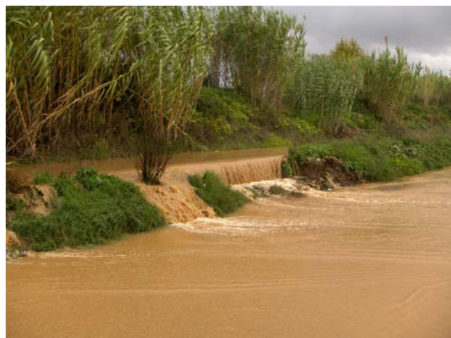
Foto 2 – O canal II do sistema de rega, que se desenvolve junto ao dique da margem esquerda do rio, intercepta os caudais derivados junto à ponte da REFER
