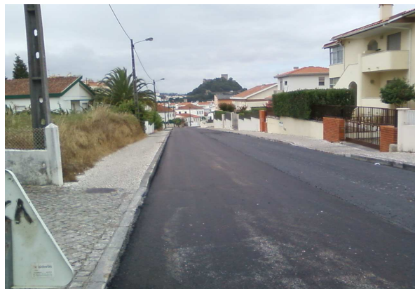
Fase final da Obra
