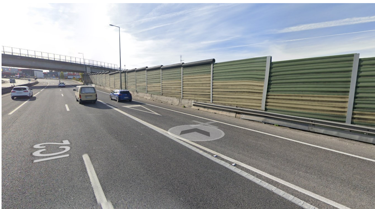
Figura 2-3 – Exemplo de barreira acústica instalada na A19 / IC2 – Nó do IC36 / Nó da EN109
