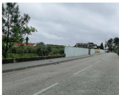
Figura 49 - Requalificação da Estrada do Oeste (parte) - Cavalinhos
