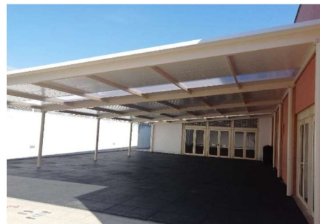
Figura 60 - Centro Escolar - Execução de cobertura
