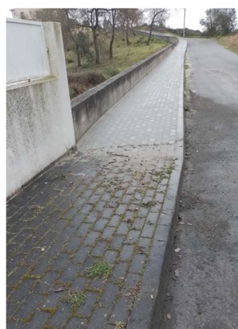
Figura 37 - Rua da Escola Velha
