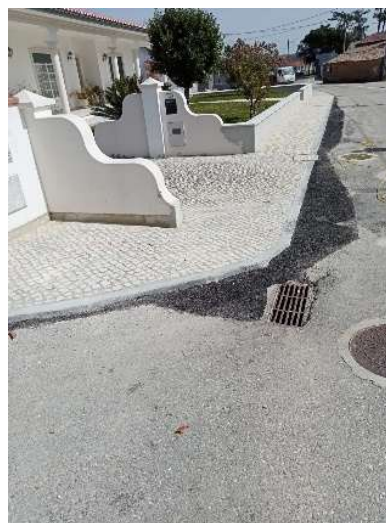
Imagem 49 – Rua José Duarte Rolo – Sismaria
