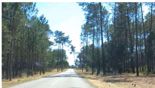
Imagem 29 – Rua José Duarte Rolo – Sismaria
