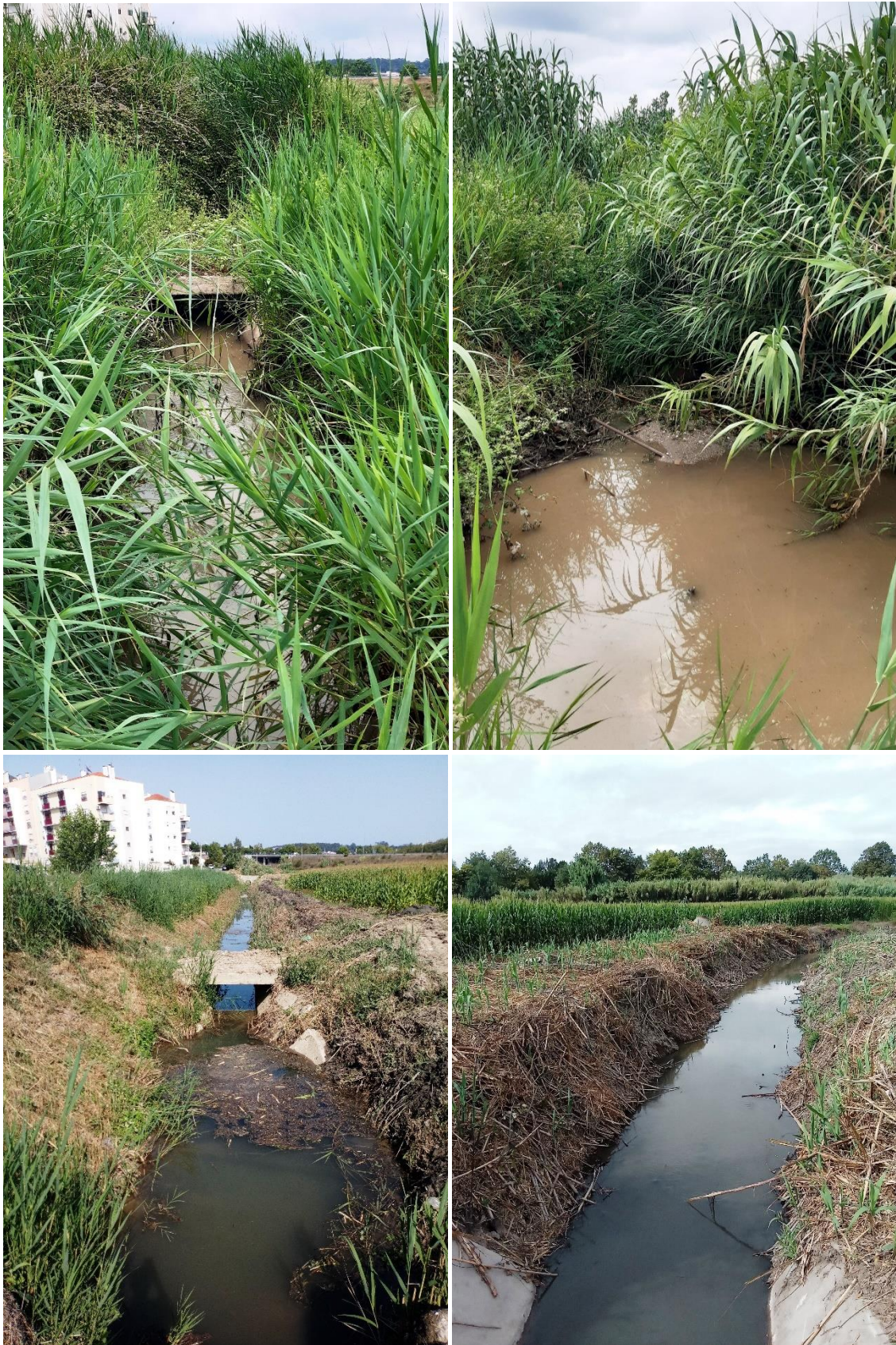
Figura 16 – Vala do Carvão: Coletor (antes e depois da intervenção, em cima e em baixo, respetivamente)
