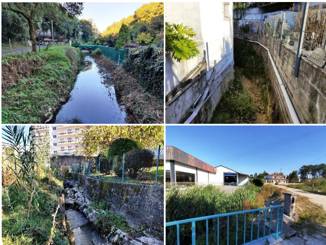
Figura 28 – Ocupação e artificialização de taludes marginais (barreiras longitudinais)
