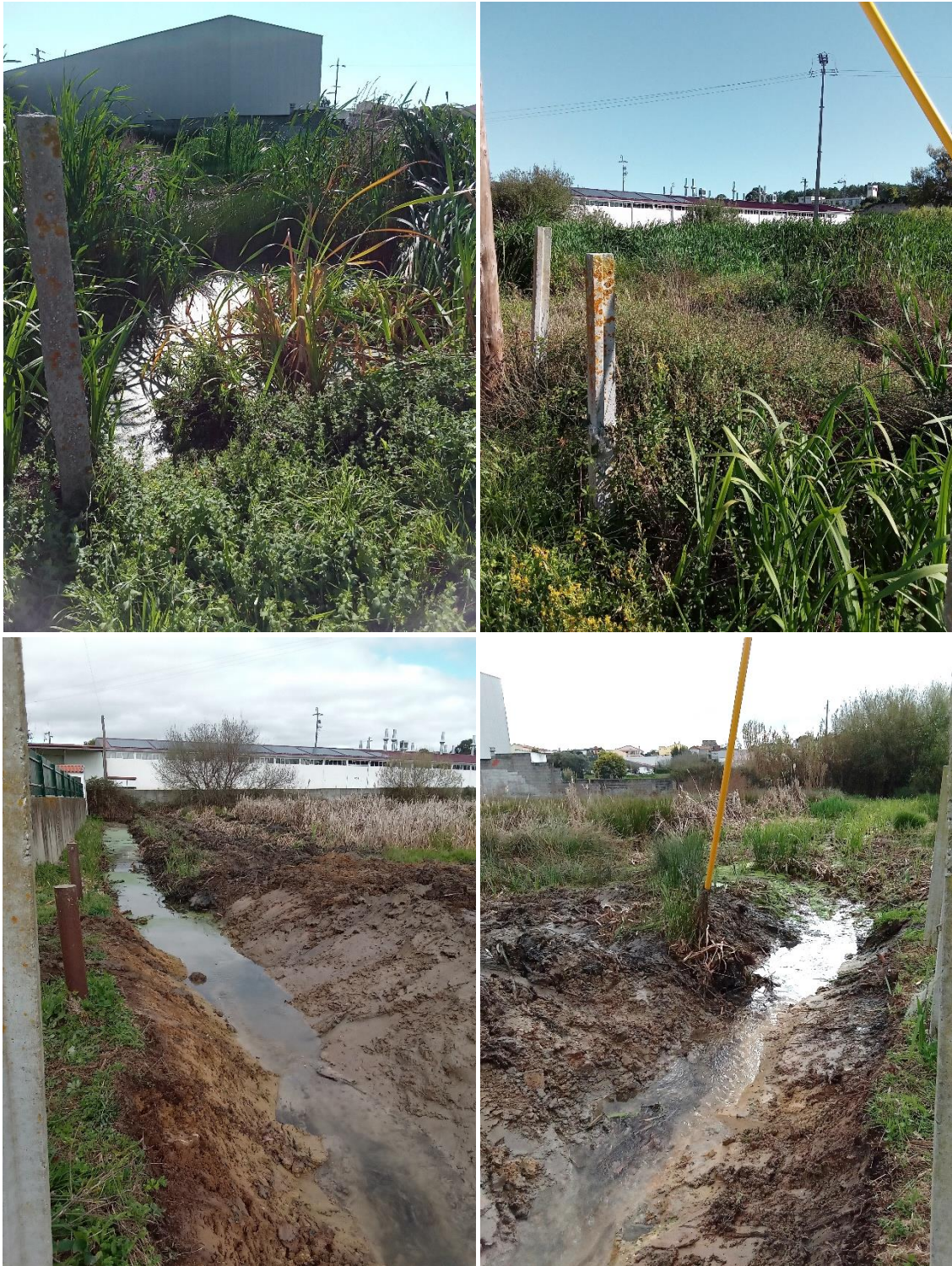
Figura 18 – Vala da Testamenteira (antes e depois da intervenção, em cima e em baixo, respetivamente)
