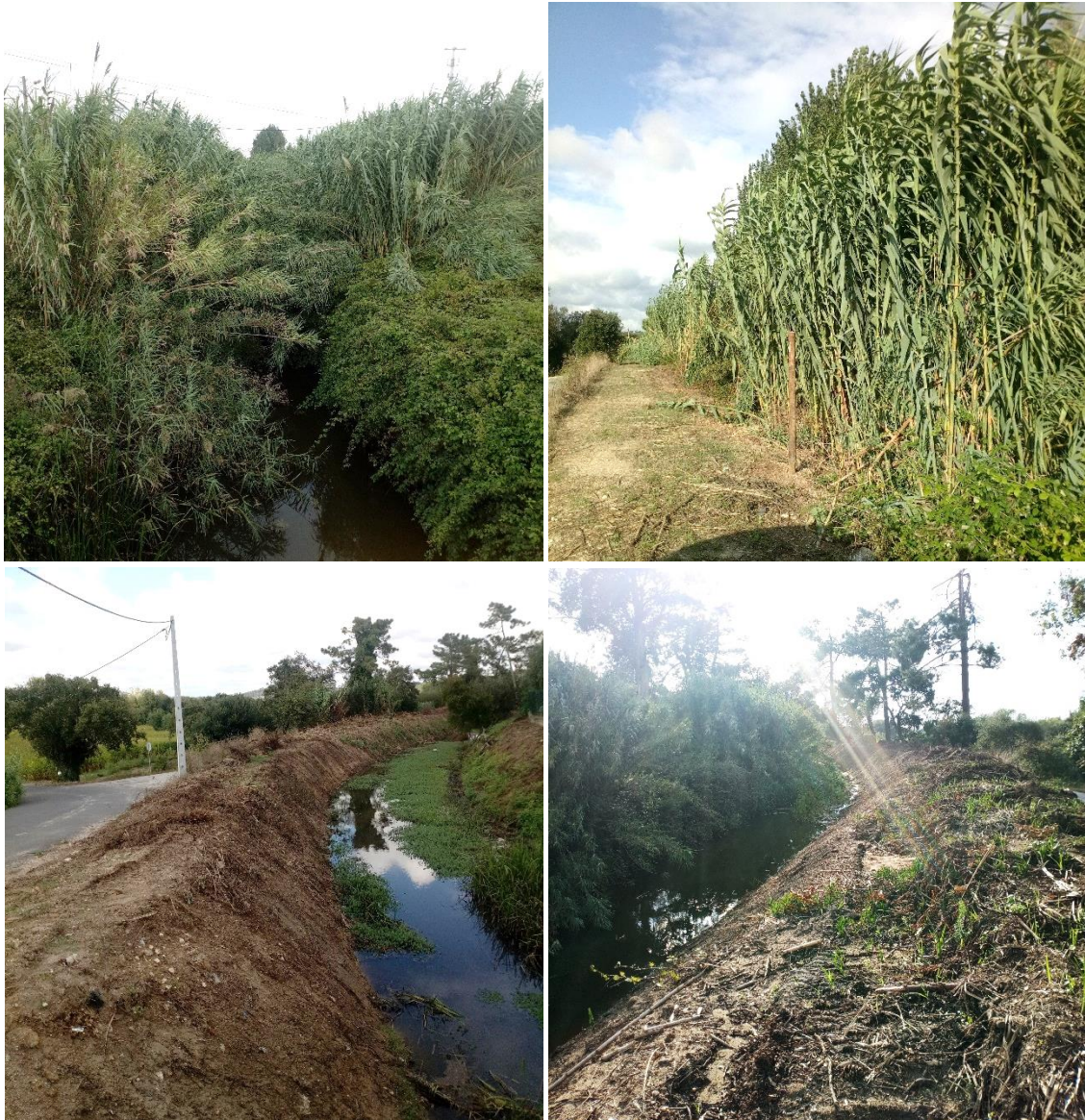
Figura 15 – Ribeira da Carreira: Coletor da vala da Aroeira (antes e depois da intervenção, em cima e em baixo, respetivamente)
