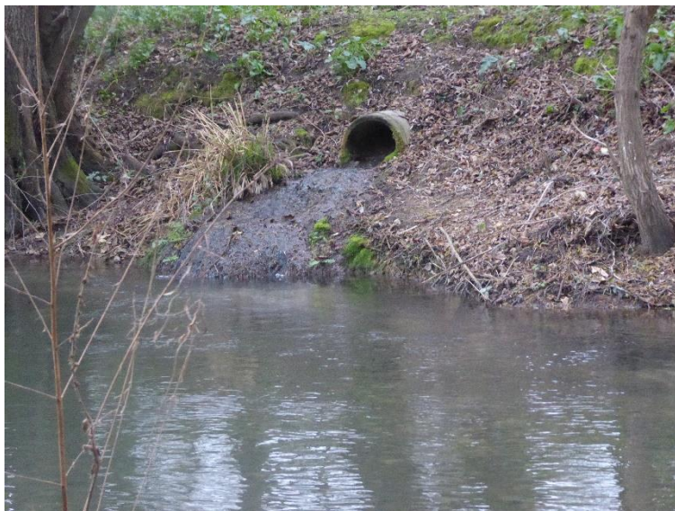
Fotografia 4 – Descargas pontuais de poluentes provenientes de efluentes domésticos de efluentes (Coord.: Lat. 39°42'51,95"N; Lon. 8°47'15,36"W)
