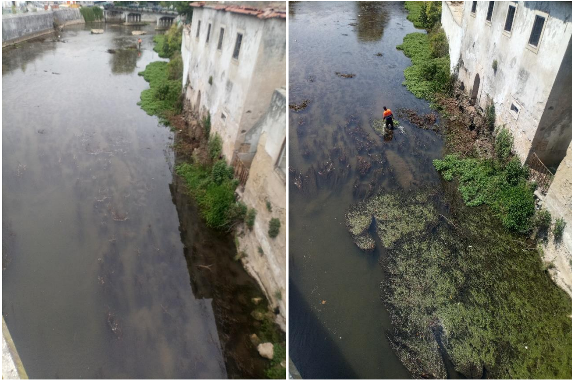
Figura 14 – Rio Lis: Açude Fonte Quente - Ponte Hintze Ribeiro
