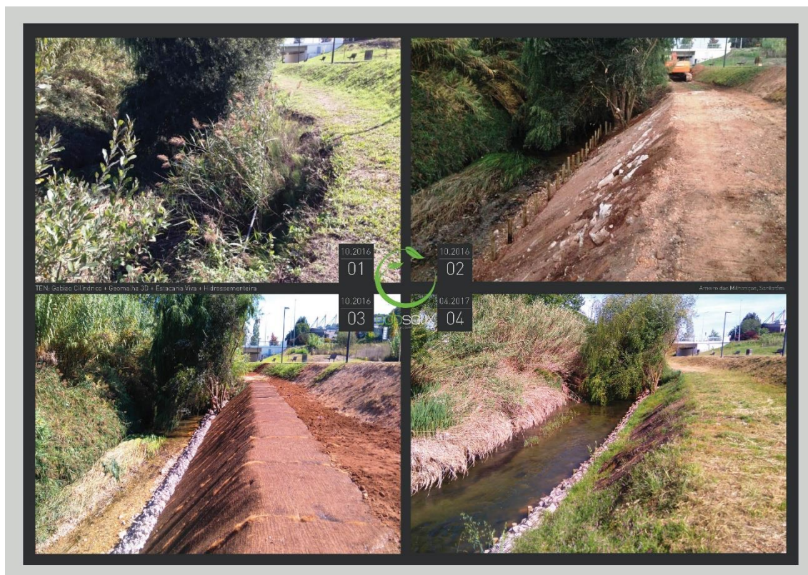
Figura 12 – Intervenção no rio Lis com técnicas de Engenharia Natural (2016)
