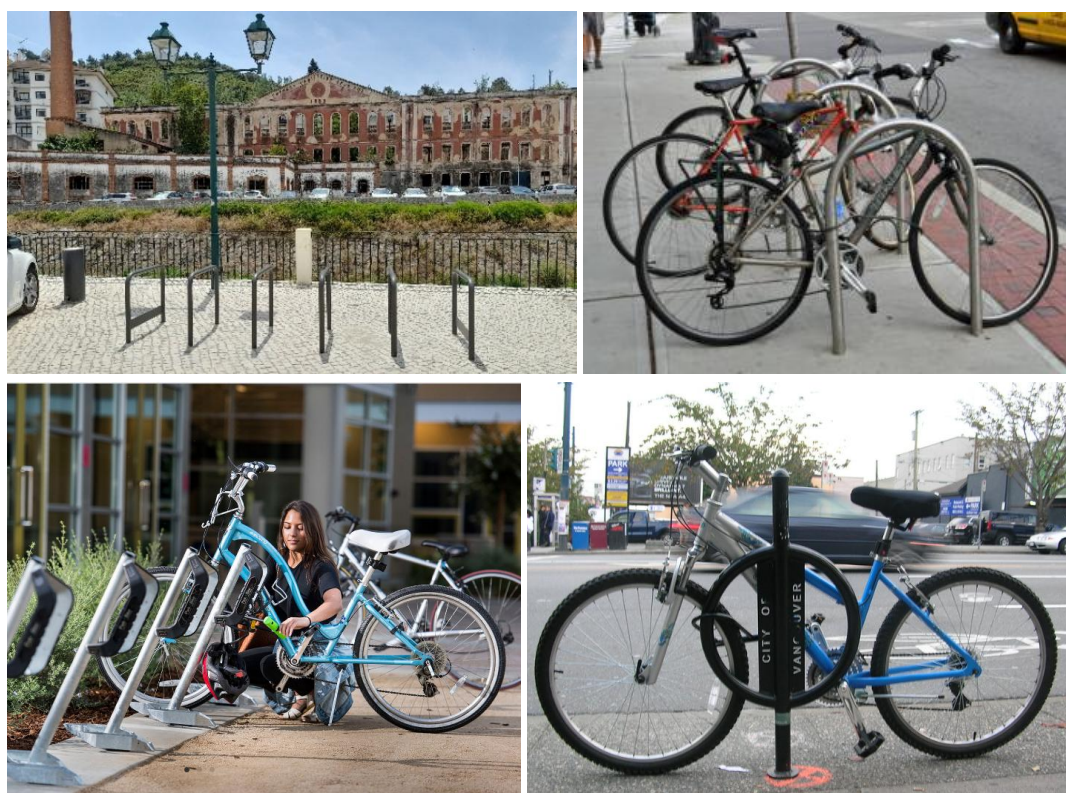
Figura 36. Exemplos de cicloparques recomendados – U invertido, “post&ring” e “wheelwell – secure”
