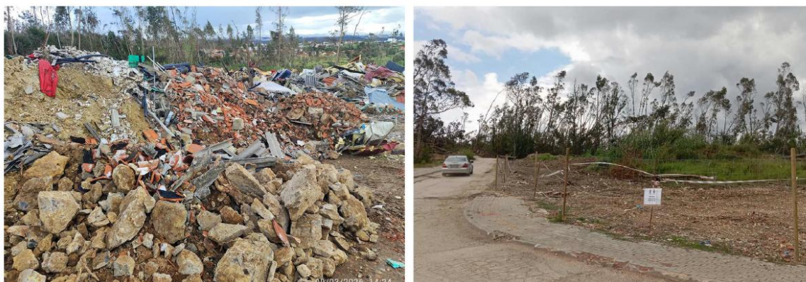
Figura 30 - Registo Fotográfico antes e depois da intervenção – Regueira de Pontes
