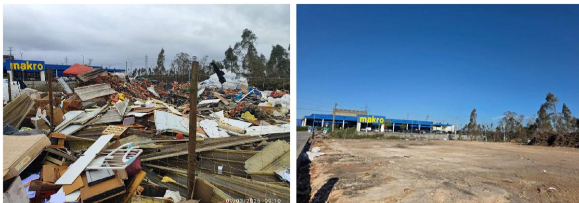
Figura 28 – Registo Fotográfico antes e depois da intervenção – Boa Vista
