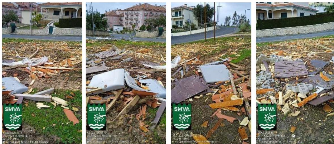
Figura 19 – Danos no Compostor comunitário do Telheiro
