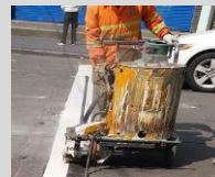
Estrada (Marcas Rodoviárias)
