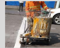
Estrada (Marcas Rodoviárias)
