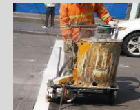
Estrada (Marcas Rodoviárias)
