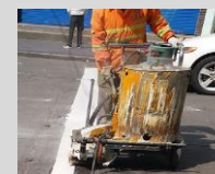
Estrada (Marcas Rodoviárias)
