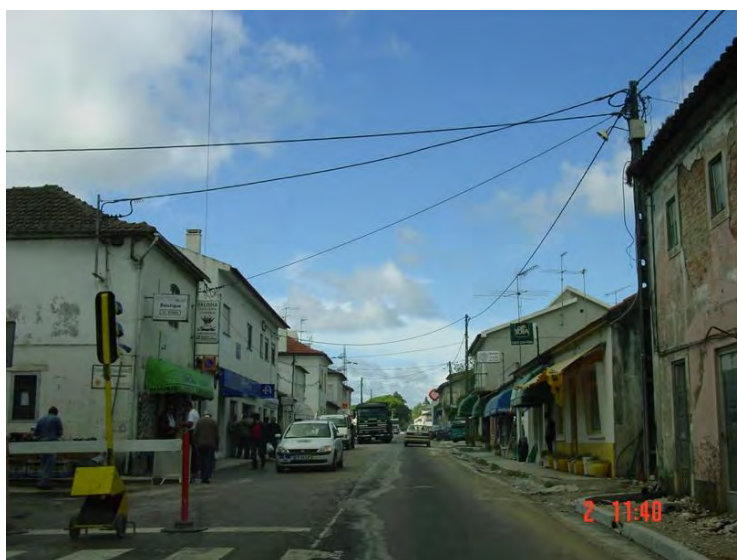
Figura 23. Aspeto da EN 356-1 junto ao centro urbano de Maceira
