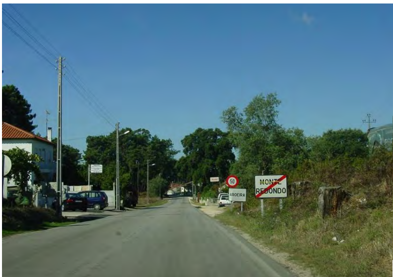
Figura 19. Aspeto da EN 109-9 junto à saída de Monte Redondo
