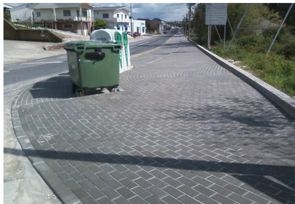
Fase final da Obra
